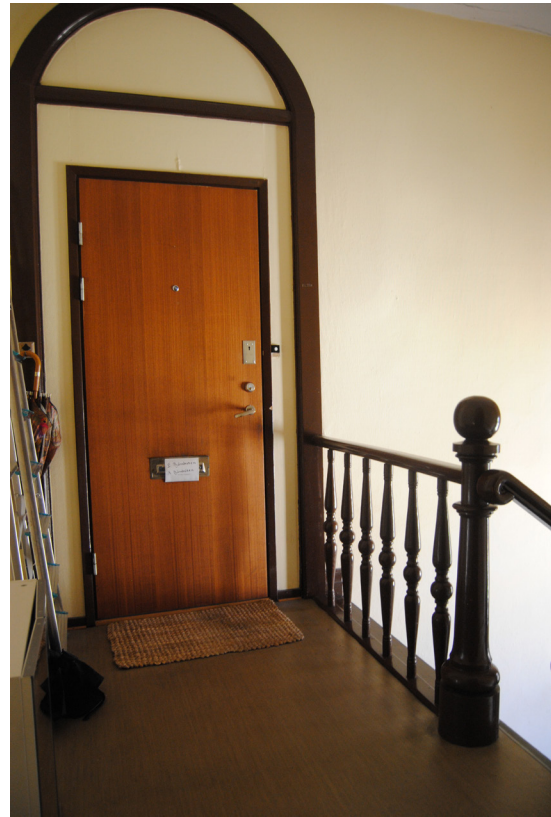
Trappans avslutning på tredje våningen, varifrån en ny trappa mot vinden föreslås.
