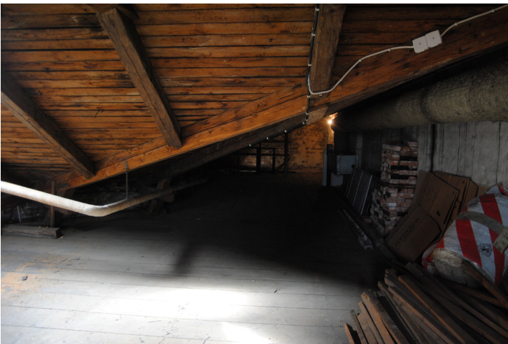
Det stora vindsutrymmet nås via gårdsflygelns låga och smala vind.
