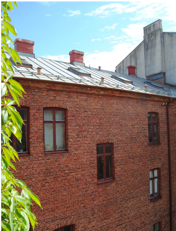
Gatuhusets mittparti och takfall mot gården.
