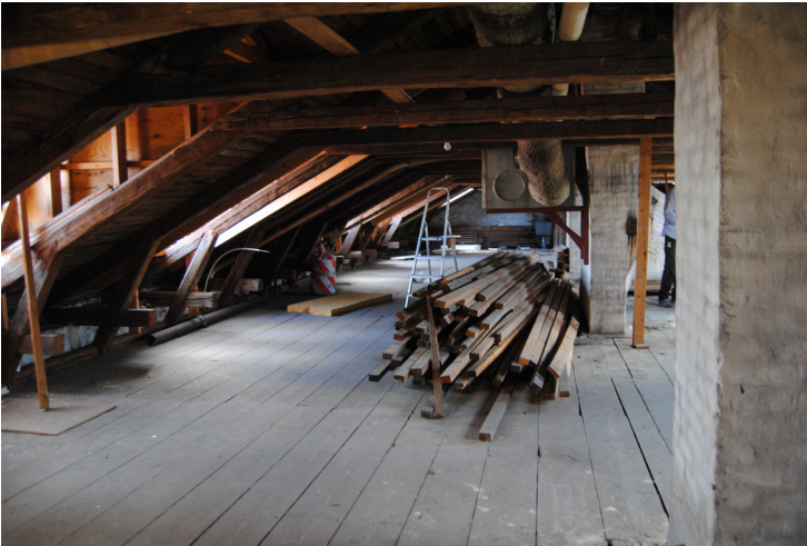
Vy mot öster med takfallet mot gatan till vänster.
