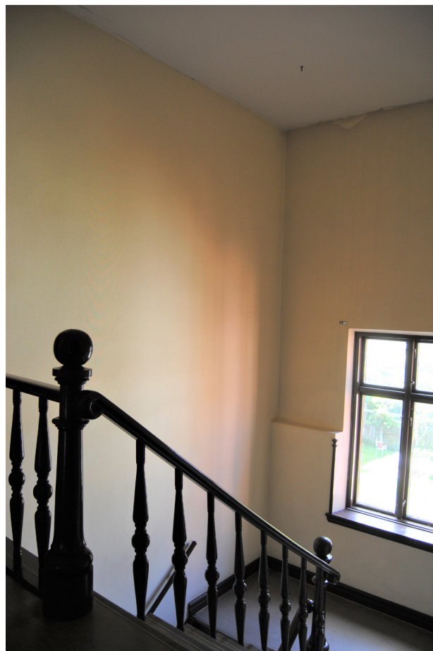
En ny vinkeltrappa, med början till vänster om den svarvade stolpen, föreslås gå från tredje våningen till vinden.
