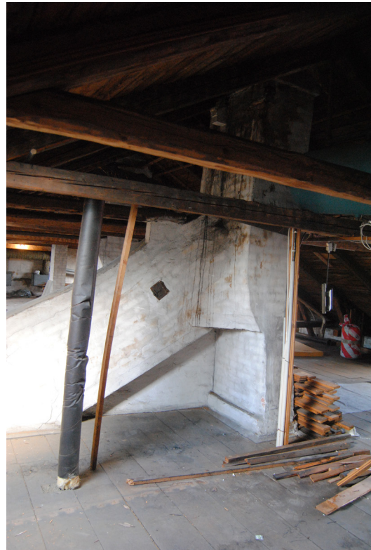
T h: Den större murstocken är centralt placerad i vindsutrymmet.
